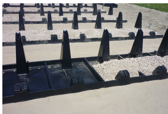
Figura 21: discarica di Goro (FE). Sono stati progettati dei supporti per i pannelli fotovoltaici del tutto simili a quelli di Roncayette
