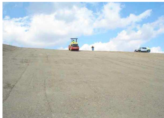
Figura 24: Preparazione del terreno prima di posare la geomembrana. Impianto di Tessman Road (US-TX)
