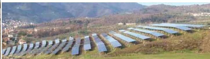
Figura 17: impianto fotovoltaico discarica di Vaiano (PO)
