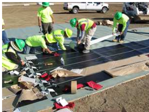
Figura 23: fase di incollaggio dei pannelli fotovoltaici sulla geomembrana. Impianto di Tessman Road (US-TX)
