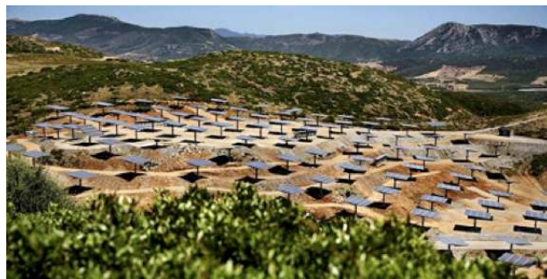
Figura 6: impianto fotovoltaico sulla discarica di Carbonia (CI)
