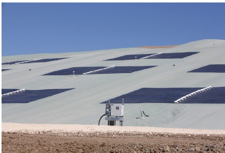
Figura 29bis: Impianto di Tessmann Road (US-TX): impianto ultimato
