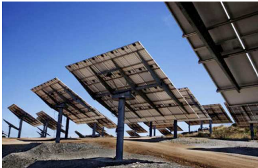
Figura 5: pannelli a inseguimento solare. Impianto di Carbonia (CI)
