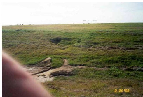
Figura 13: Cedimenti differenziali in una discarica in Pennsylvania (USA)
