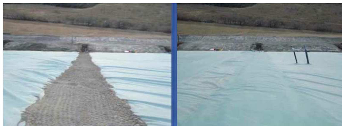
Figura 28: Impianto di Tessman Road (US-TX): particolare sulla copertura delle trincee con geomembrana
