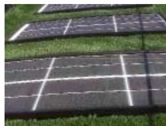
Figura 36: copertura di discarica con erba sintetica e pannelli solari. Impianto nella discarica di Crazy Horse (US-CA)
