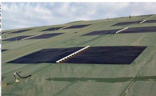
Figura 12: impianto a pannelli flessibili. Discarica di Tessman Road (US-TX)
