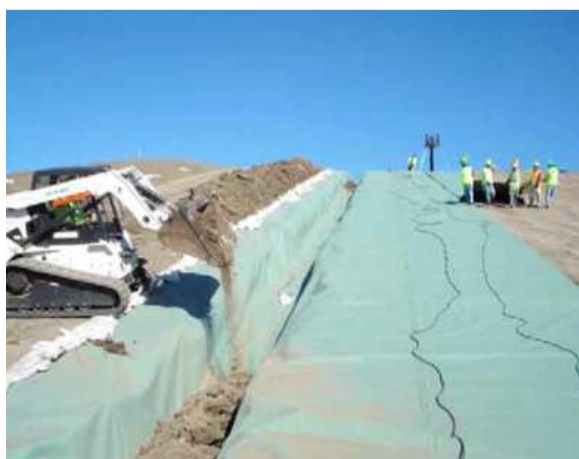
Figura 26: Impianto di Tessmann Road (US-TX): fase di costruzione delle trincee ancoranti
