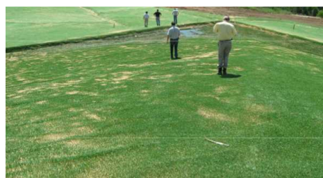
Figura 35: copertura di discarica con erba sintetica. Discarica di Crazy Horse (US-CA)
