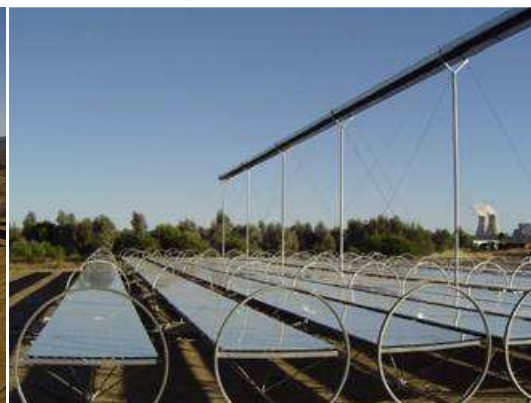
Figura 10: CSP con collettori Fresnel. Impianto di Liddell (AUS)
